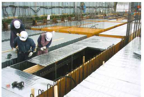
▲短尺キーストンと在来型枠の施工例
