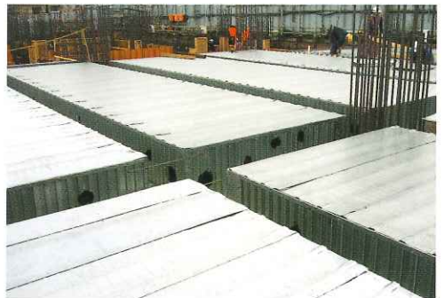
▲床、梁ともに打込み型枠で施工した例 (作業工程が一段と短縮できます。) ●セコフォーム+Lデッキプレート
