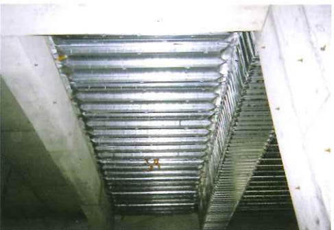
▲在来型枠、Lデッキ、セコフォームで施工した例
