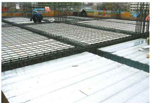
▲在来型枠とLデッキ(配筋中)
