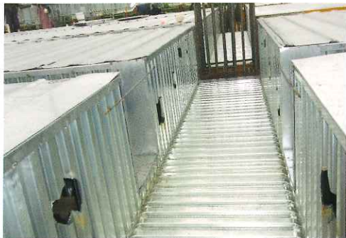
▲Lデッキ・セコフォームで施工した例 (作業工程が一段と短縮できます。)
