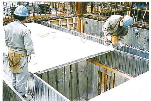
▲Lデッキ・セコフォームで施工した例 (作業工程が一段と短縮できます。)
