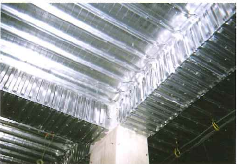
▲Lデッキ・セコフォームで施工した例
