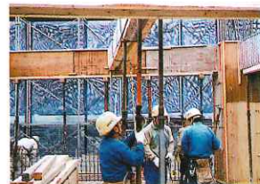
▲支保工の設置
