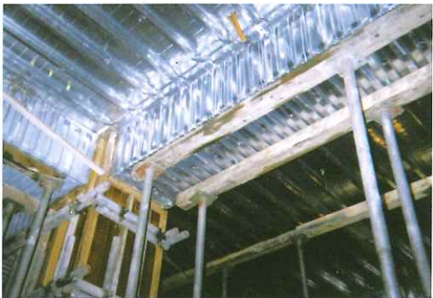
▲Lデッキ・セコフォームで施工した例 (梁下支保工の解体前)
