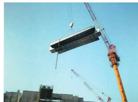
▲荷降り・間配り
