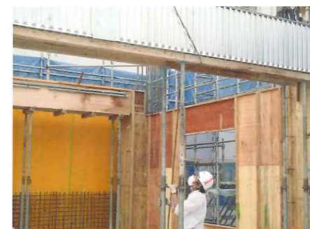
▲支保工の設置
