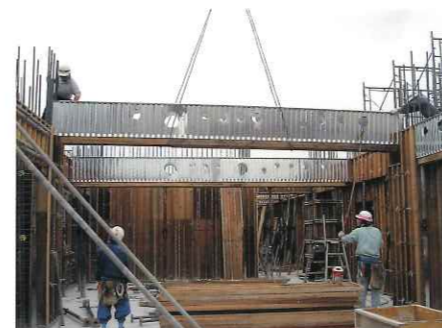
▲クレーンによる柱型枠に取付
