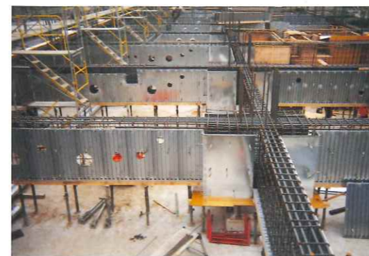
■免震用梁の施工例
