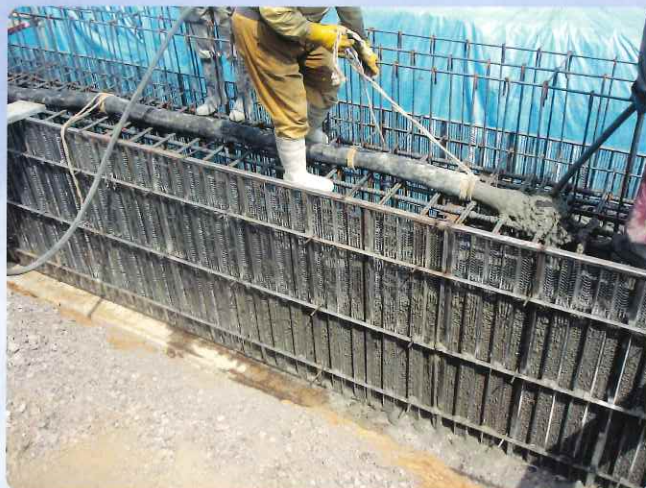
② コンクリート打設1
