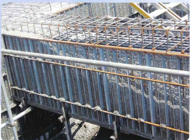
③ コンクリート打設2
