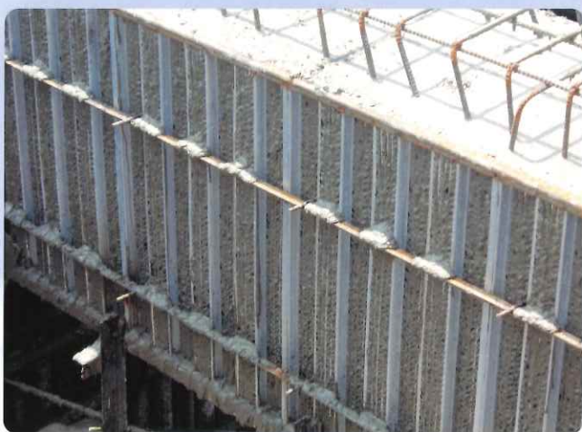
④ コンクリート打設後
